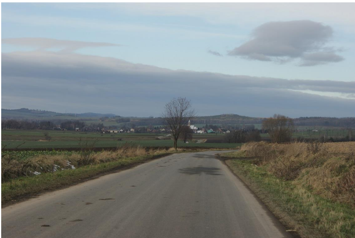
Rysunek 1. Stan drogi Branice-Bliszcyce, wzdłuż której częściowo funkcjonuje odwodnienie
